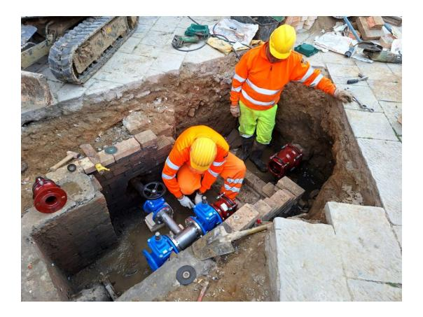
I lavori attualmente in corso, per un investimento di circa 60mila euro, prevedono, nel tratto che va da via Salicotto a via Duprè, la posa di 40 metri di nuova tubazione in ghisa sferoidale e il rifacimento dei pozzetti di manovra e di tutti gli allacci. Complessivamente sono finora stati sostituiti circa 290 metri di condotta idrica dell'anello di Piazza del Campo: per completare i lavori ne restano ulteriori 100 metri, per un investimento di circa 200mila euro.
