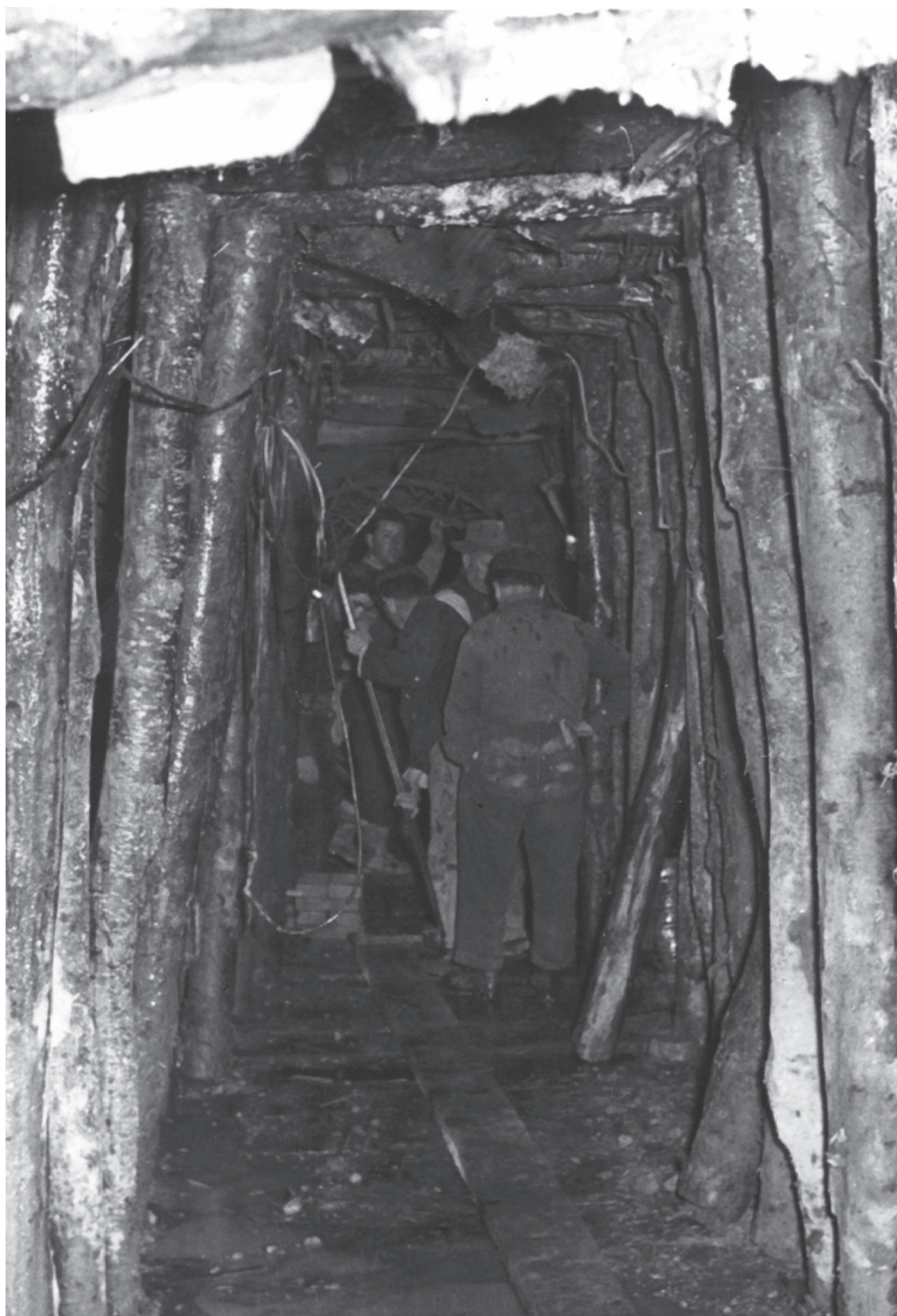
^ Particolare della puntellatura dei fianchi della galleria.
