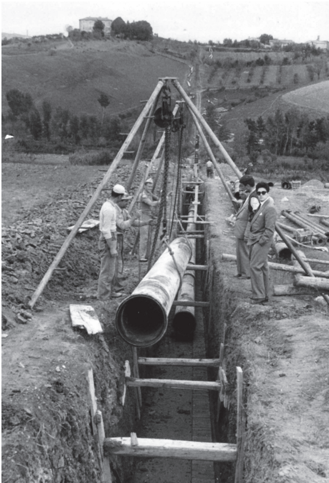
^ Nuovi tubi di acciaio da 500 mm. vengono posati sulla platea in calcestruzzo.
