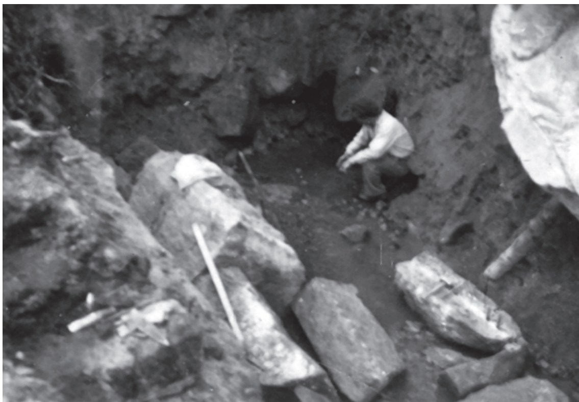
^ In alto: primi lavori di sbancamento alla sorgente Burlana.
