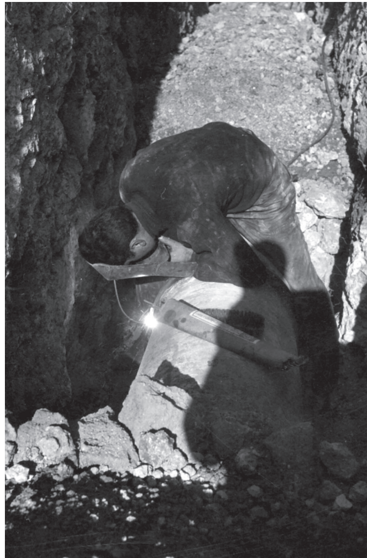
^ Un piombatore provvede alla saldatura di una delle frequenti rotture dei tubi.
