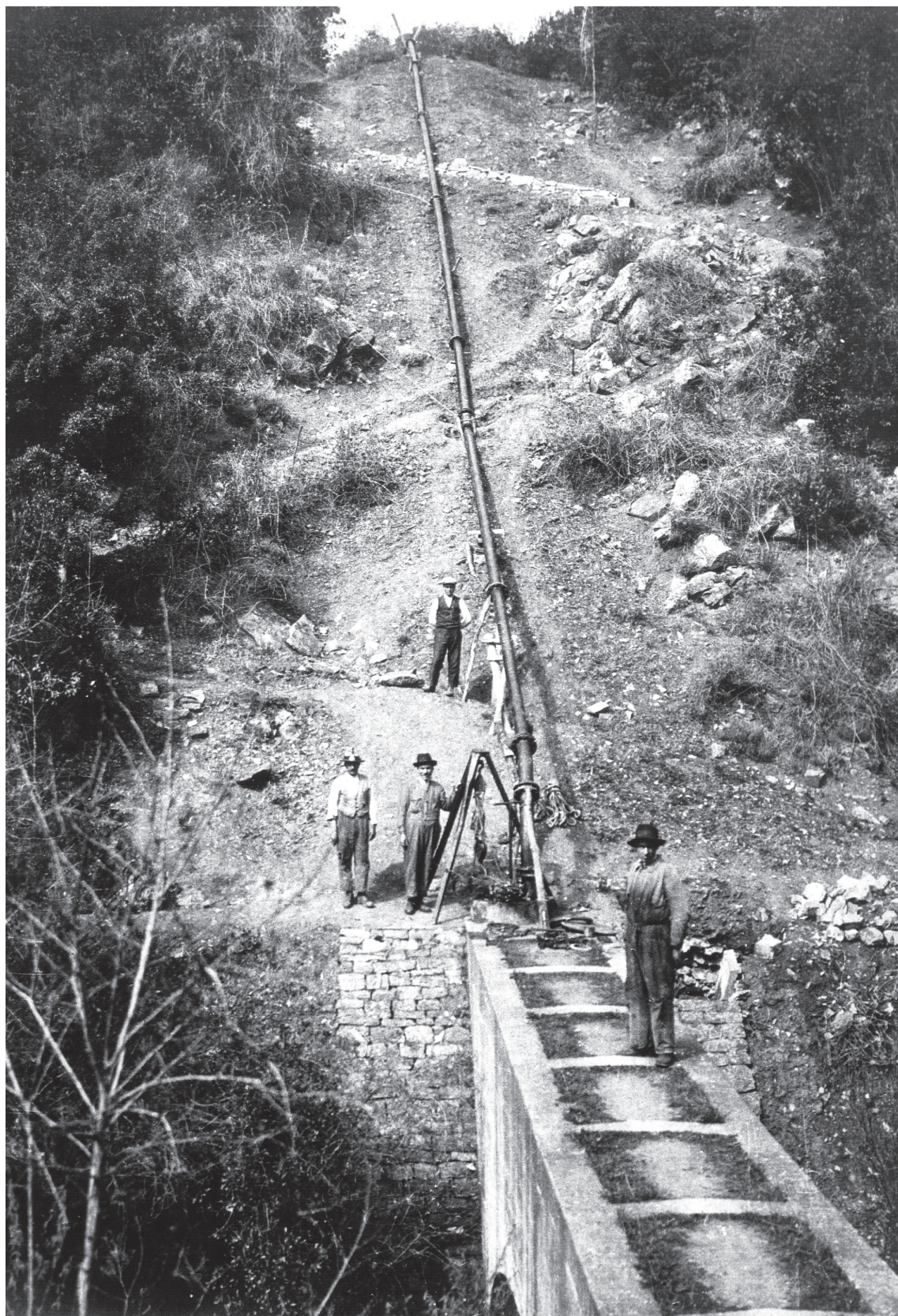
^ La condotta inserita nel ponte del torrente Scodellino.
