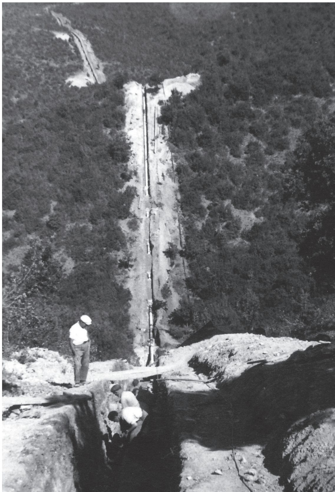
^ Lavori di sostituzione della vecchia condotta dal disconnettore di Poggio d'Arna a Siena. (1958)
