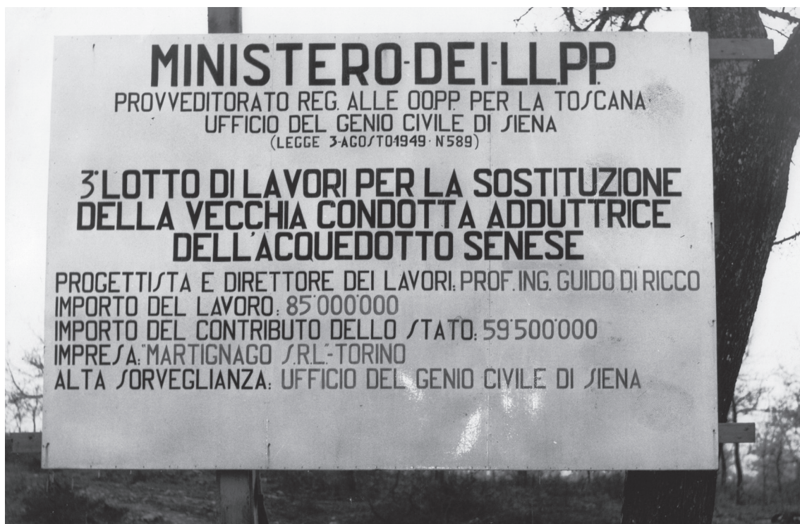
^ Cartello relativo alla sostituzione delle tubature nel terzo lotto tra Grotti e Fogliano.
