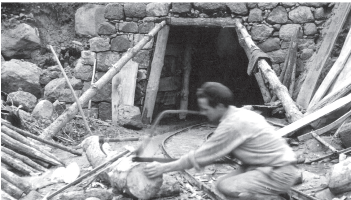
Particolare dell'ingresso della prima galleria Burlana, poi abbandonata.
