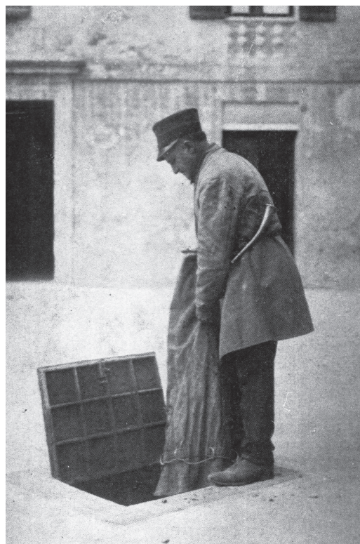
^ Un pozzetto "Augias" dove veniva raccolta l'immondizia. (1928)
