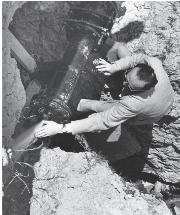
^ Un tecnico controlla le vecchie tubature in ghisa.
