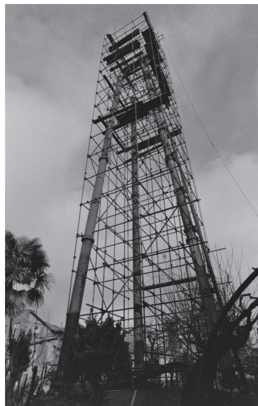
^ Colonna piezometrica. I lavori per smontare la colonna piezometrica effettuati nel corso del 1982.
