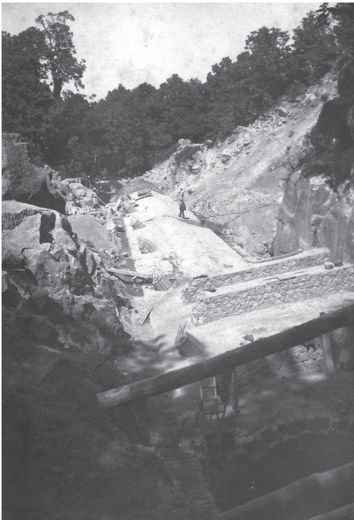
^ Lavori di costruzione dell'edificio di presa. (1908)
