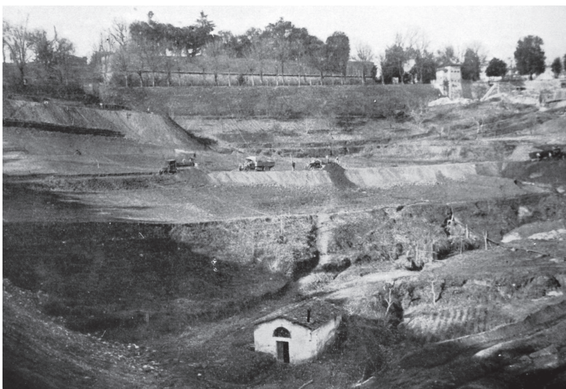
^ Gli imponenti lavori per riempire la valle del Rastrello, destinata ad ospitare il nuovo stadio inaugurato l'8 dicembre 1938.
