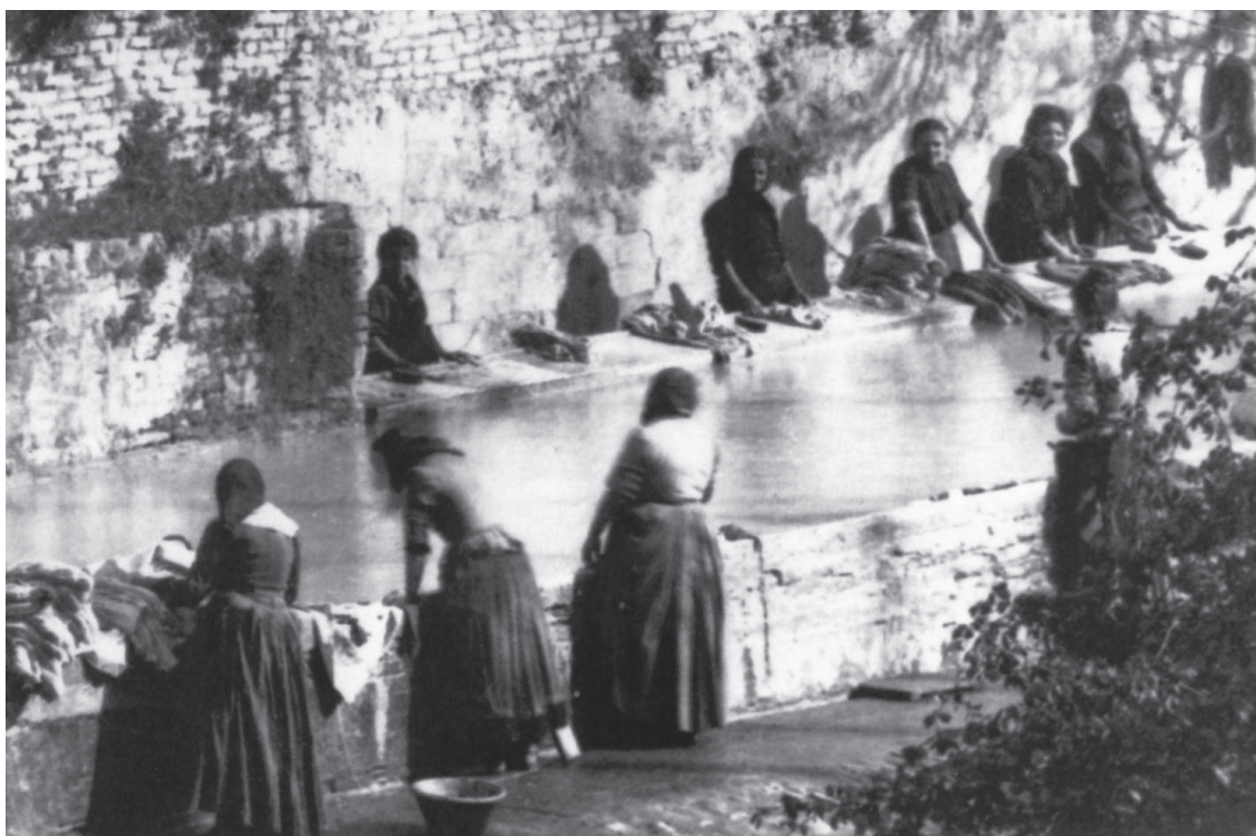
^ Lavandaie alla Fonte di Ovale.
