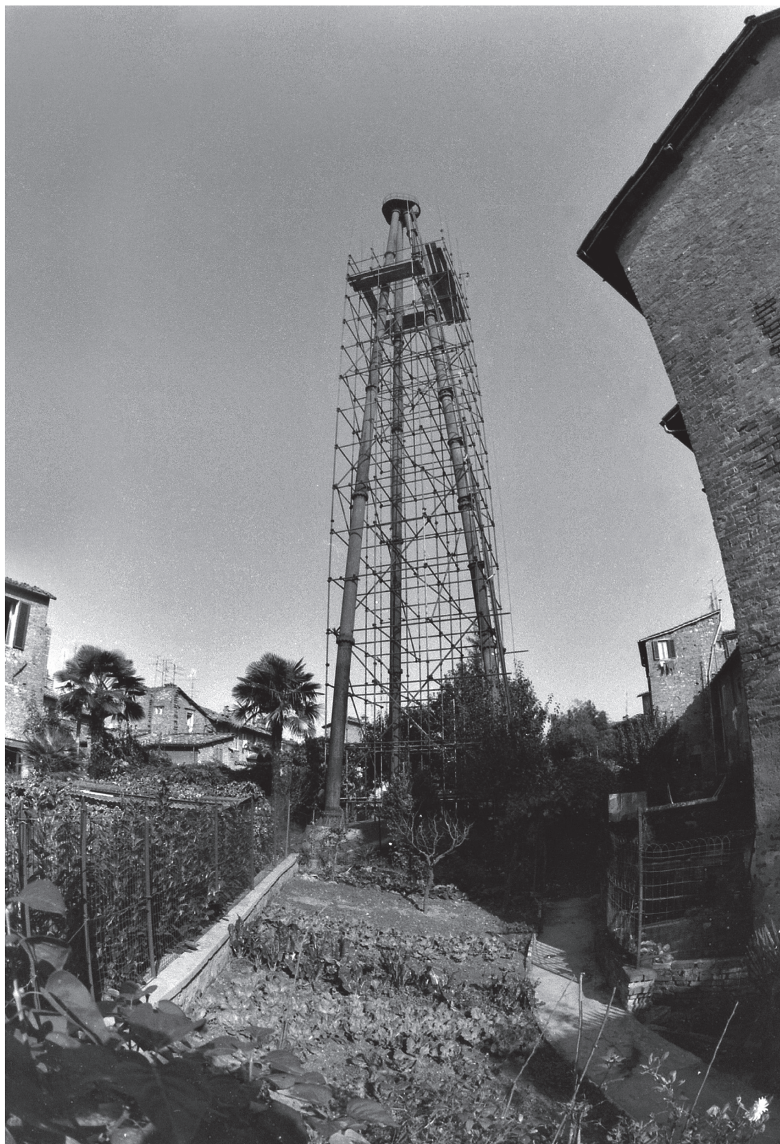
^ La colonna piezometrica, posta in un piccolo orto cui si accede da via Stalloreggi, viene smontata.
