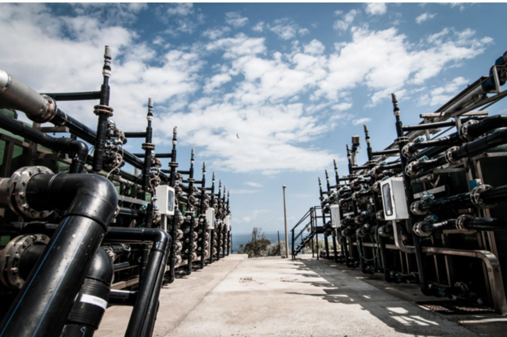
è praticamente distillata, viene remineralizzata, resa potabile e immessa nella rete idrica.
