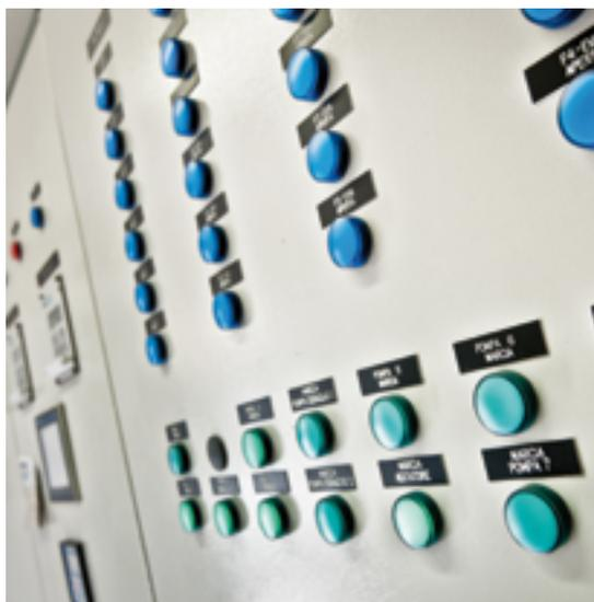
aprire o chiudere a distanza le valvole, per aumentare o diminuire la portata dell'acqua che scorre nelle tubature, a seconda delle esigenze.
