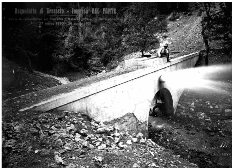
Ponte in calcestruzzo sul torrente Melaccio. Scarico delle condotte.
