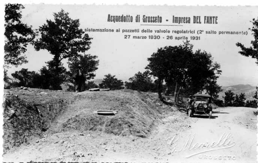
La sistemazione dei pozzetti delle valvole regolatrici.
