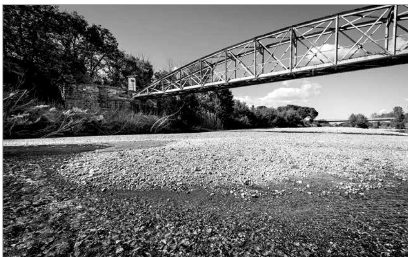
Il ponte sulle Trasubbie oggi (foto: Stefano De Nanni)
