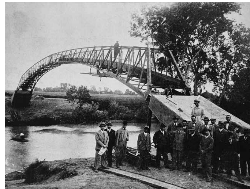
Ponte sulle Trasubbie in costruzione, maestranze e tecnici.
