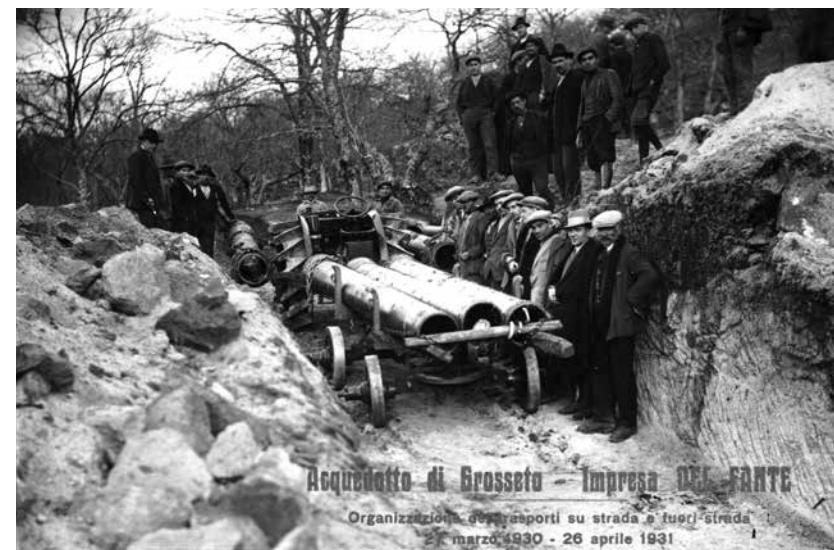
Posa delle tubazioni lungo il tracciato, organizzazione del trasporto.
