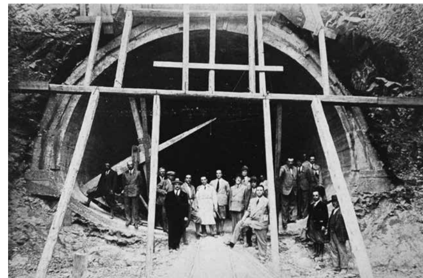
Lavori del grande serbatoio del Grancia. Visita sindacati fascisti.
