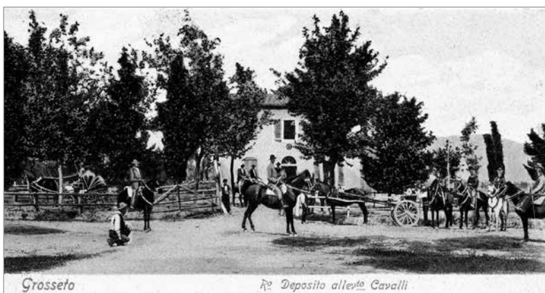
Grosseto - Ingresso al Deposito Alleo. 1º Cavalli
