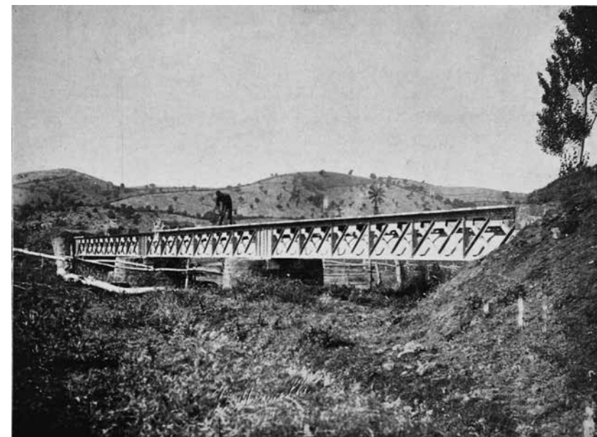
Costruzione di una passerella metallica per fa passare le tubature.
