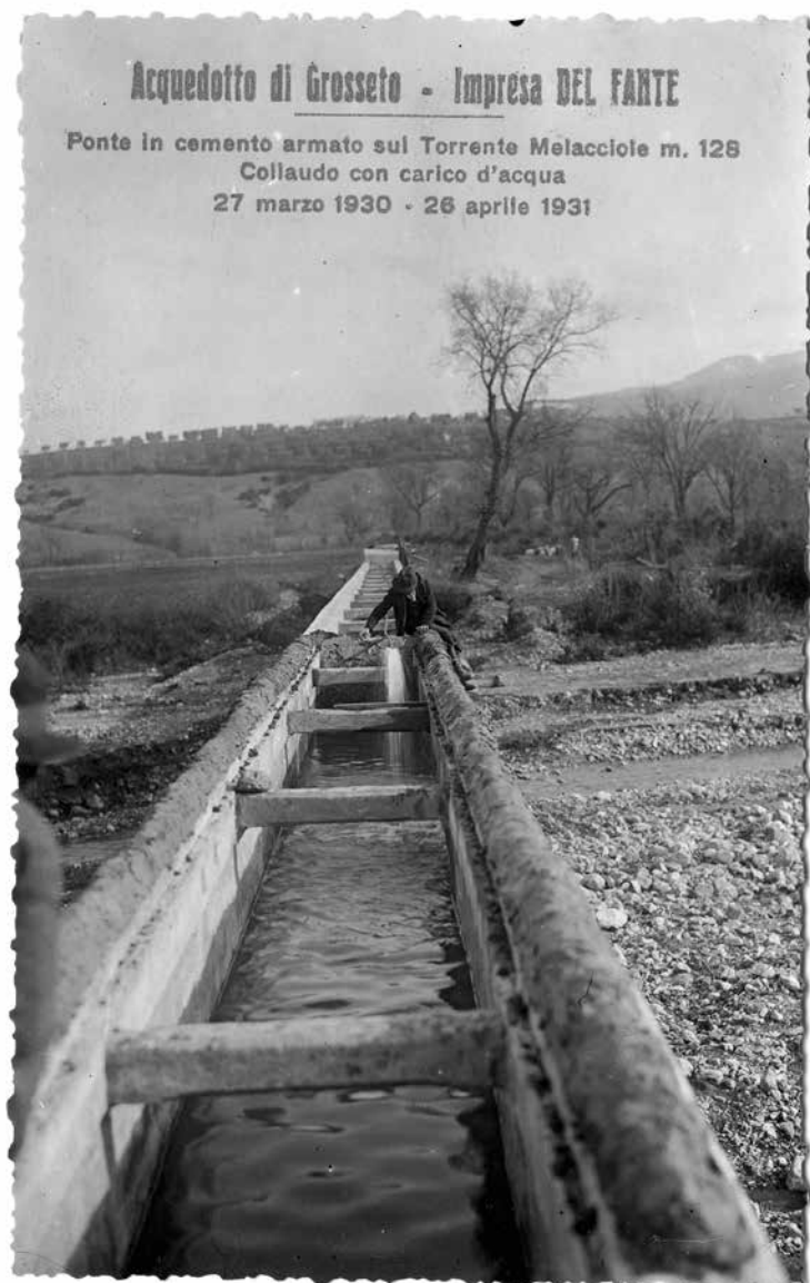
Ponte in cemento armato sul torrente Melacciole, collaudo con carico d'acqua.
