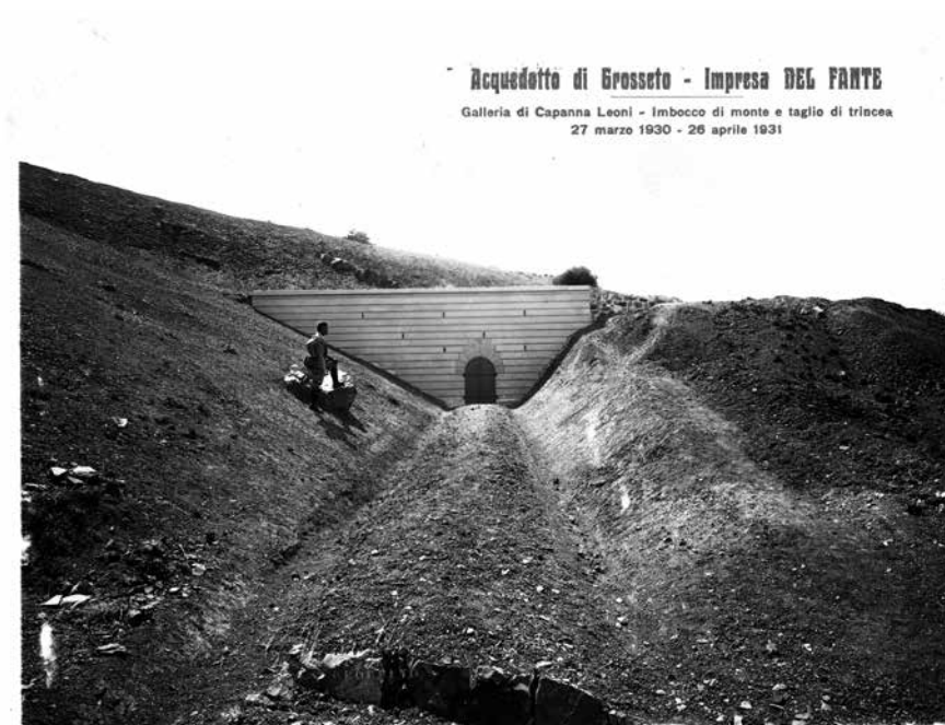
Imbocco e taglio di trincea della galleria del Monte Leoni.
