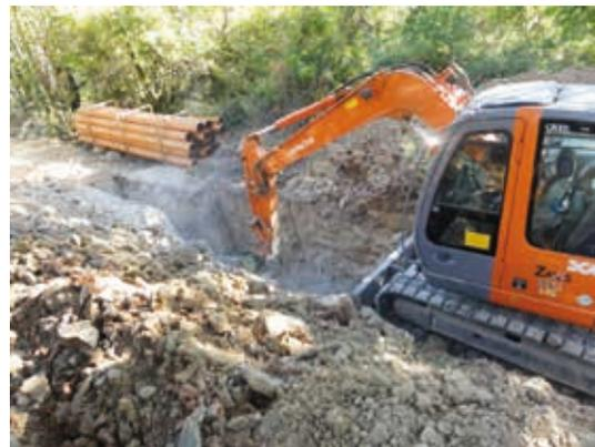
bie con la demolizione degli esistenti manufatti in c.a. esterni alla vasca, ingombranti e in deperimento.
