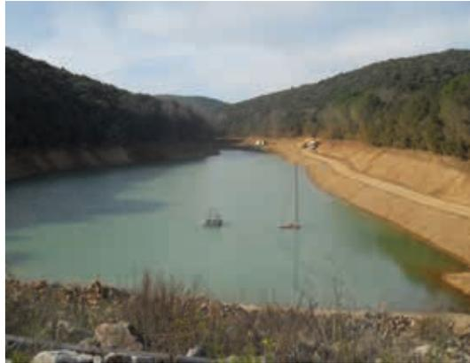
vo e asporto di materiale terrigeno. L'opera, inserita nel Piano operativo di Emergenza per la crisi idropotabile del 2010, quando conclusa sarà in grado di fornire un maggior apporto idrico proveniente dall'opera di presa sul fiume Pecora. Sarà inoltre agevolato l'accesso al lago mediante il rifacimento della strada.
