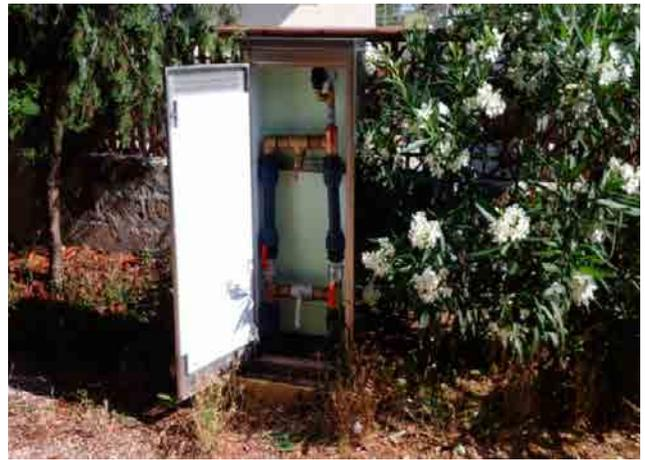
Come si può ben vedere, il punto di prelievo è alloggiato in un contenitore in acciaio dove è collocato il tubo derivato dalla condotta da monitorare nel quale l'acqua scorre in modo continuo e dove saranno installati il rubinetto per il prelievo, le valvole di regolazione, il manometro ed il misuratore di cloro residuo.
