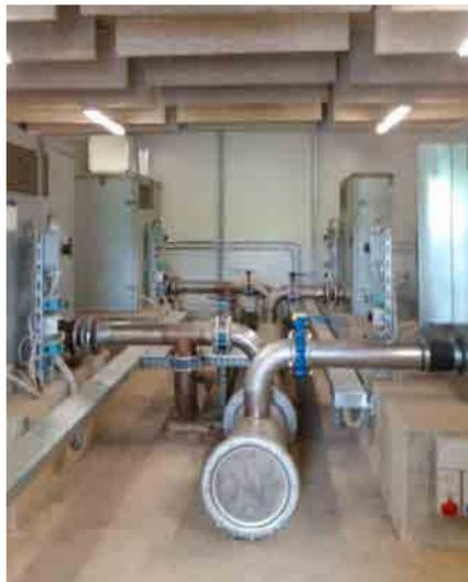
L'adeguamento del 2014 riguarda in particolar modo le opere elettromeccaniche dell'impianto, la sezione di grigliatura, in cui è stata installata un'ulteriore macchina e di insufflazione d'aria, il rifacimento dell'impianto elettrico. È stato inoltre installato il telecontrollo precedentemente non esistente.
