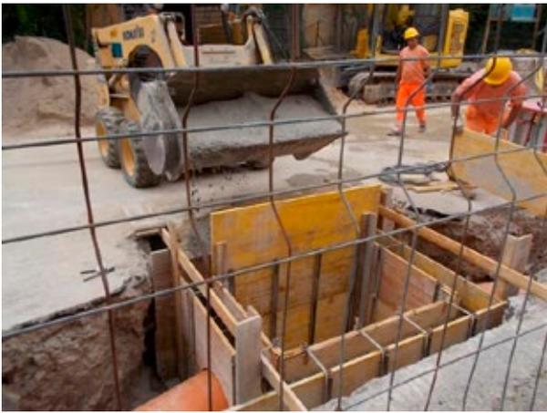
**Figura 3. Realizzazione del pozzo scolmatore**
