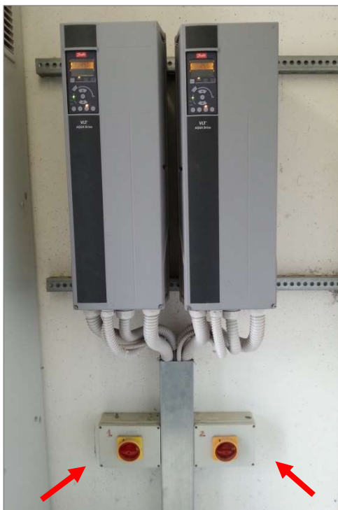
Figura 4 – Installazione a parete con sezionatori locali.
