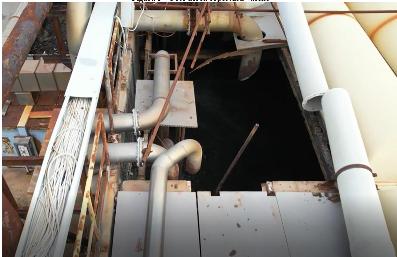
Figura 4 – Foto porzione di copertura crollata, visibile setto divisorio esistente tra la vasca W-5C e la W-5B
