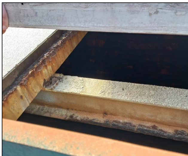
Figura 8 – Sistema di sostegno della copertura esistente
