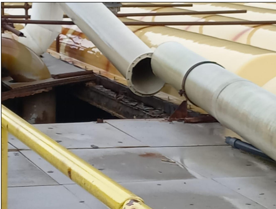
Figura 7 – Foto porzione di copertura crollata, visibile trave di sostegno copertura esistente
